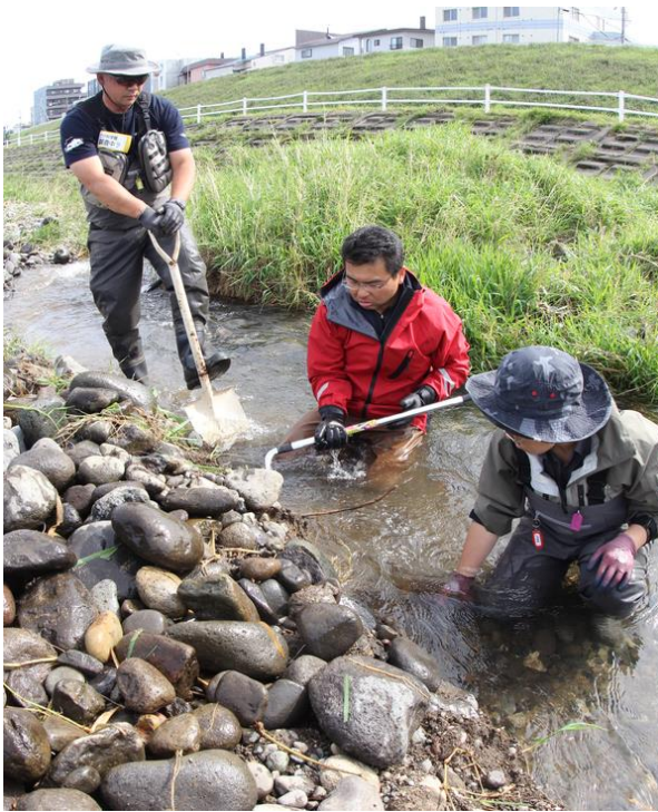
2018 年 10 月 5 日 水路拡幅作業
