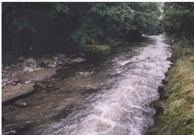
写真1 河川改修により生じた上流域の河床低下、岩盤化
