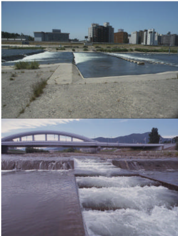
図3 6・7号床止と設置された魚道 上：魚道設置前、右岸より左岸側を見る。 下：設置された魚道、下流より上流側を見る。
